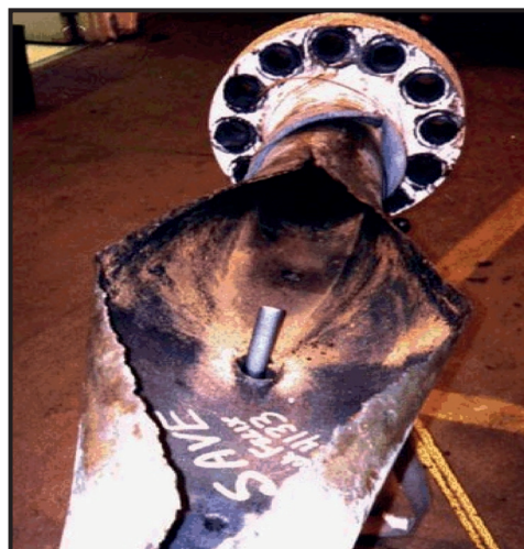
酸性プロセス薬品（スケール防止剤）による腐食 （写真提供：Energy Institute, London）
